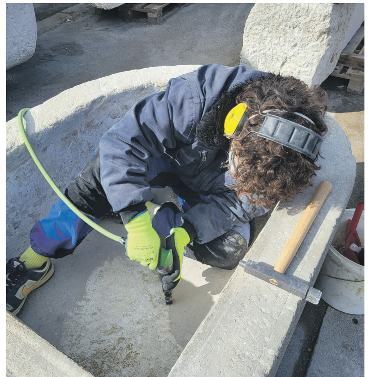
Steinmetze müssen beim Sanieren teils auf engem Raum arbeiten.
